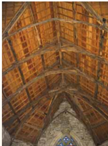
Charpente d'origine traitée et remise en place
