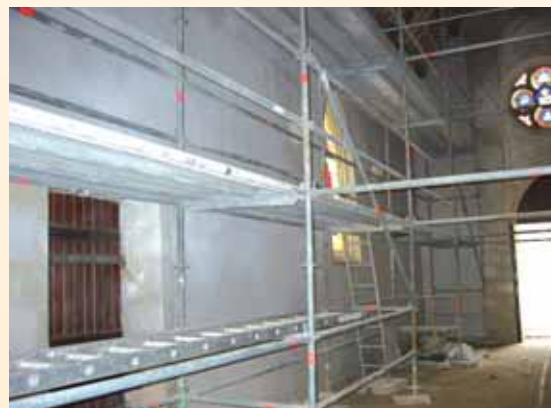
Réalisation d'un nouveau crépi à la chaux sur les murs de la nef
